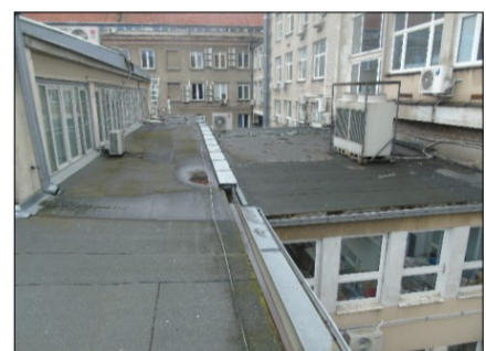
Fot.2 Widok na łącznik
