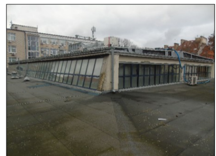
Fot.1 Widok z części niższej
